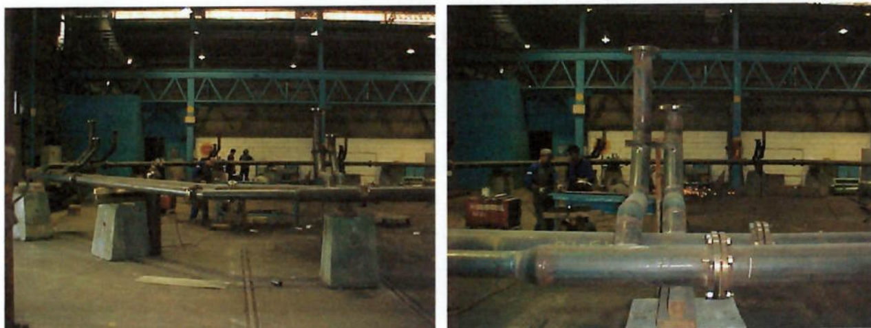
Fig 2.7 - Montagem da Tubulação do Sist. de Refrigeração de um Hidrogerador
