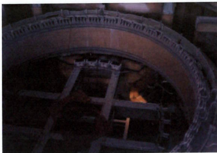
Fig 2.9 – Estator e Sapata de Quatro Pistões sobre a Cruzeta (Ilha dos Pombos)
