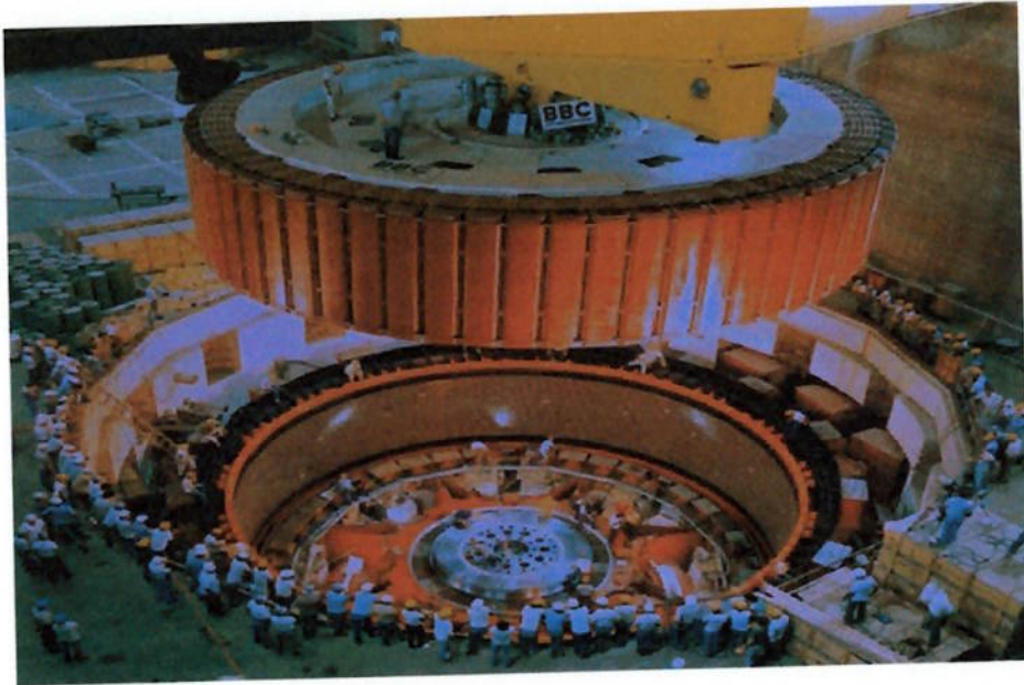
Fig 2.13 - Descida de um rotor da Usina de Itaipú
